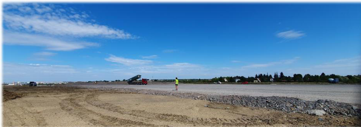
Měření radiačních veličin při stavbě komunikace v úseku Běchovice – dálnice D1
